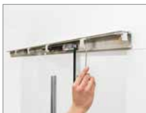
4. Montera panelhållaren med samma insexnyckel
