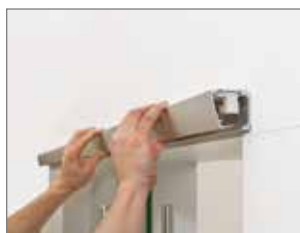
5. Kläm fast täckprofilen
