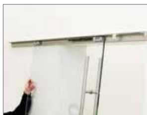
3. Haka i dörrbladet i löpskenan framifrån
